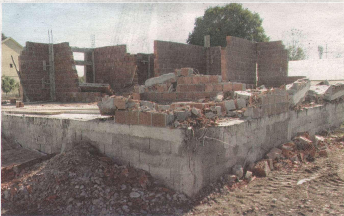
Građani neinformisani o svim negativnim posljedicama besprane gradnje
