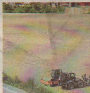
Pogled na novo sazidano jalovište
